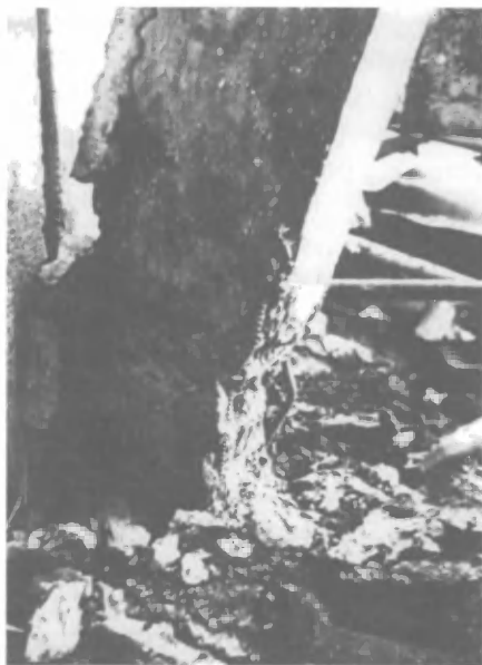
Характер разрушения внецентренно сжатой колонны по случаю 1, а также по случаю 2, когда напряжение растяжения в арматуре площадью A_s близки к предельным значениям
